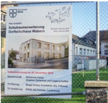
Baubeginn im Zentrum von Wabern
